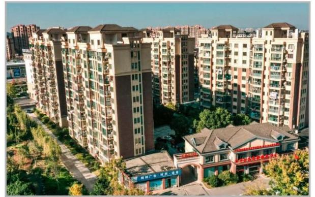
◎ 新中商公寓高层工程 省级安全质量标准化示范小区，框架十一层，3.2万㎡
